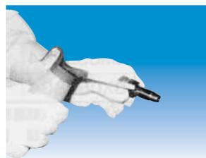
7-2 ホースが取付けられた締金具を万力にくわえ、芯金具をスパナで右向きにねじ込みます。芯金具の六角部が締金具に当たるまでねじ込んで下さい。これで金具の取付完了です。
